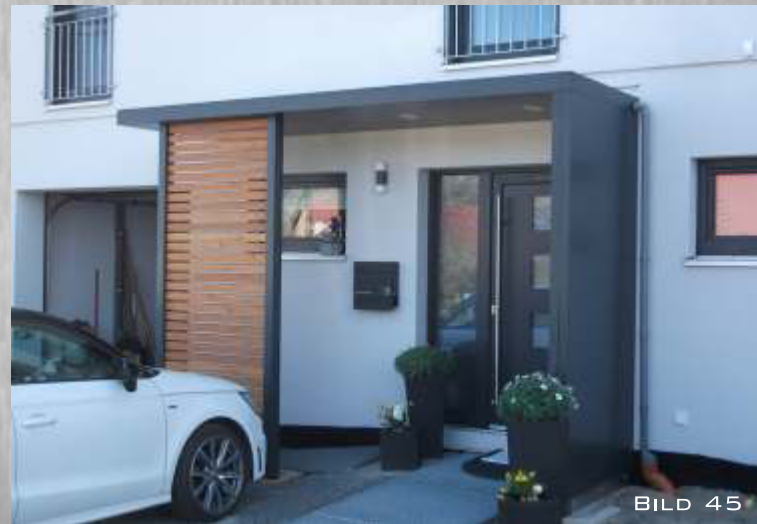
BILD 45: VORDACH MIT HOLZELEMENT, SEITENPANEEL UND BELEUCHTUNG
