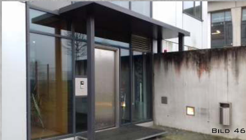
BILD 46: VORDACH MIT 3X STÜTZPFOSTEN
