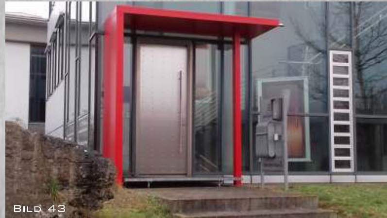
BILD 43: VORDACH MIT STÜTZPFOSTEN UND SEITENPANEEL
