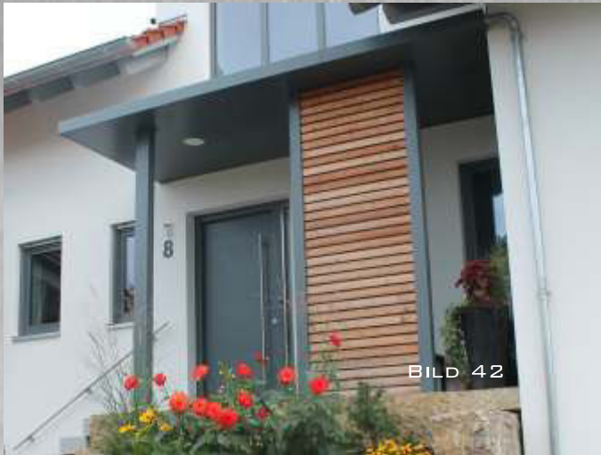
BILD 42: VORDACH MIT STÜTZPFOSTEN, HOLZELEMENT UND INTEGRIERTER BELEUCHTUNG
